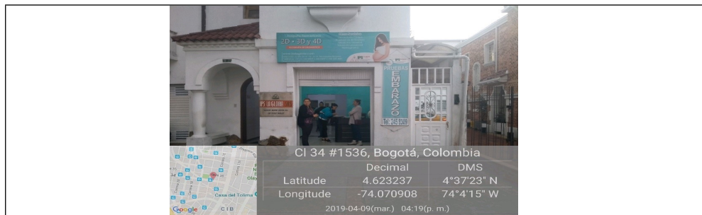
Fotografía No. 1. Elemento de publicidad exterior visual tipo AVISO EN FACHADA sin registro ante la Secretaría Distrital de Ambiente y otros elementos instalados tipo pendón y aviso adicional en fachada. Foto del 09-04-2019
